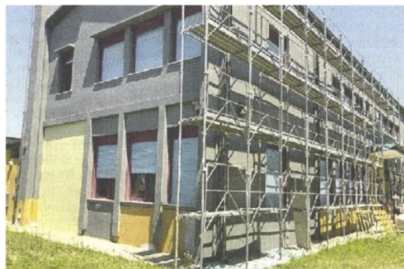
VIA MONTI I lavori di ristrutturazione dell'ex scuola
